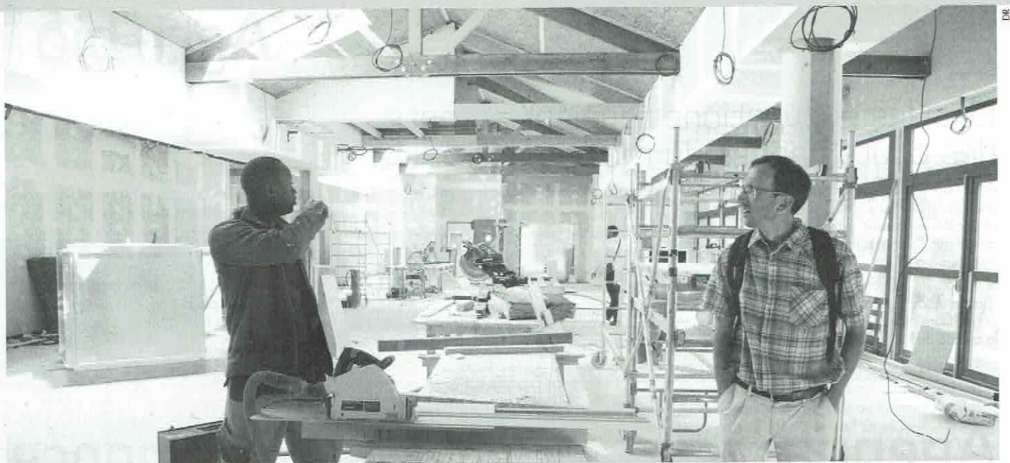
▲ La structure de l'ancien marché couvert de Rosny a été préservée pour bâtir l'école
